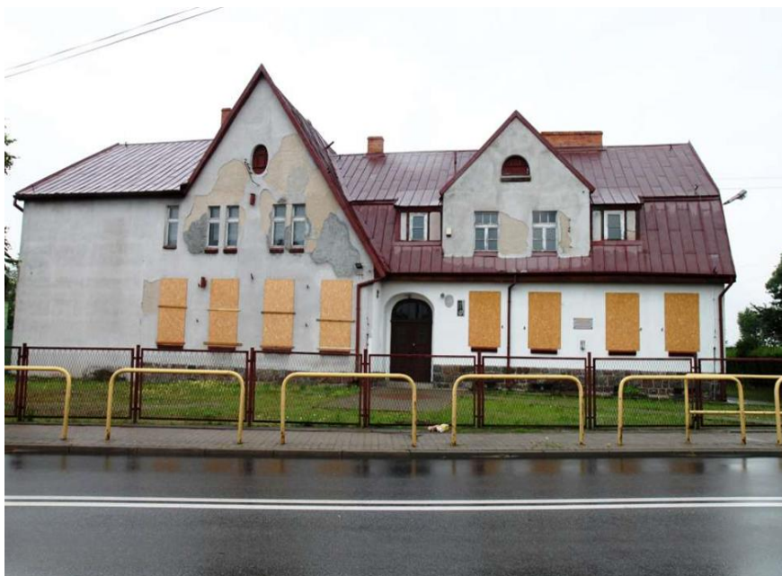
Fot.12. Obiekt w Paterku
