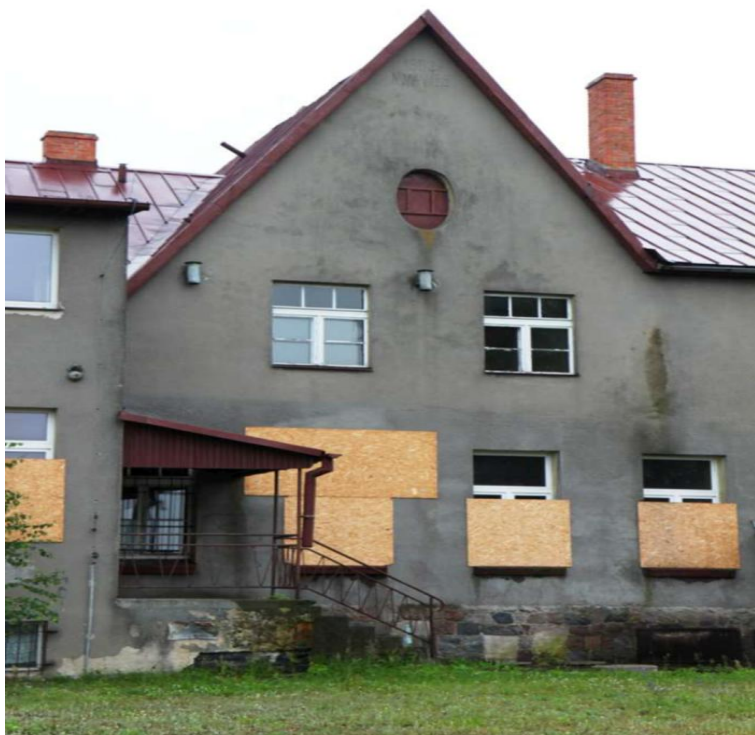
fot. 13. Obiekt w Paterku
