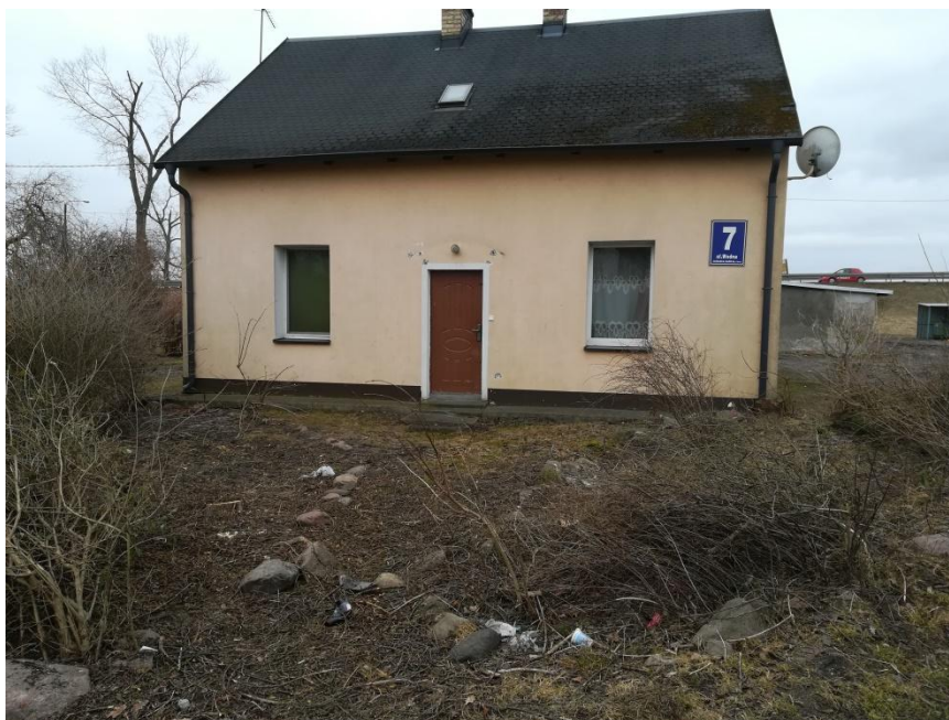
Fot.1. Budynek, ul. Wodna
