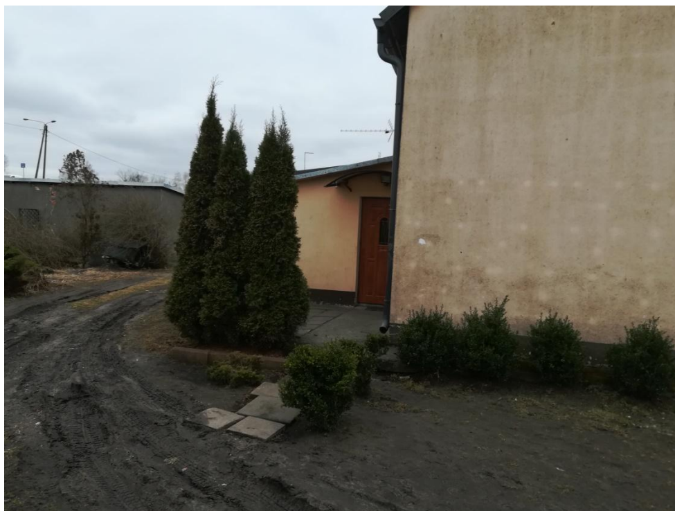
Fot.3. Budynek, ul. Wodna 7
