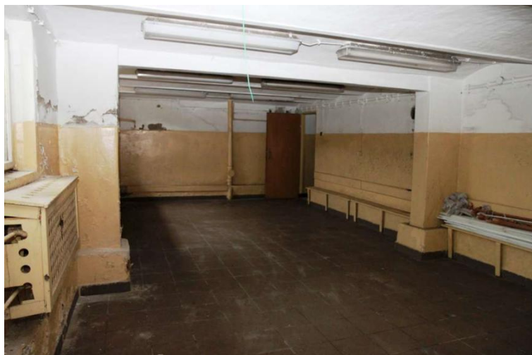
fot. 14. Obiekt w Paterku
