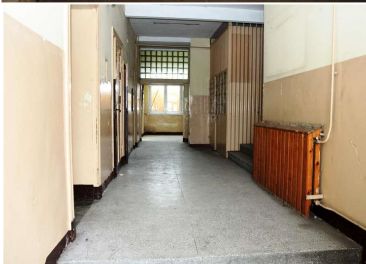
fot. 15. Obiekt w Paterku
