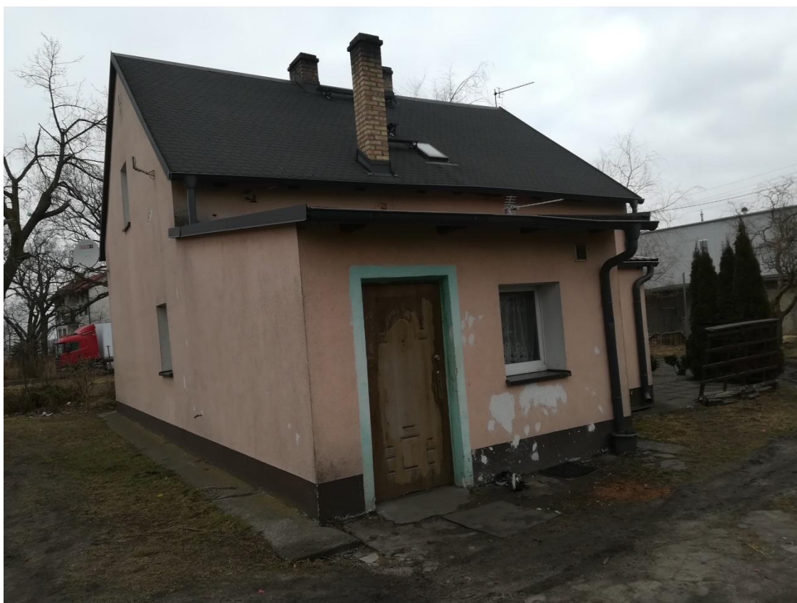
Fot.2. Budynek, ul. Wodna 7
