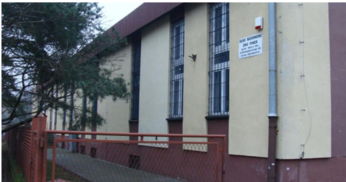
Fot. 6. Budynek, ul. Gimnazjalna 10
