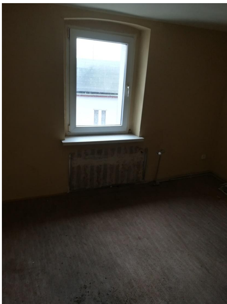
Fot.4. Budynek, ul. Wodna 7
