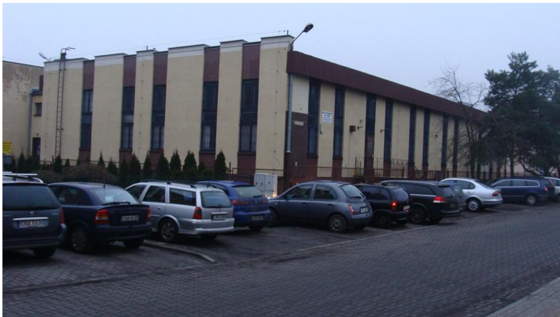
Fot. 5. Budynek, ul. Gimnazjalna 10
