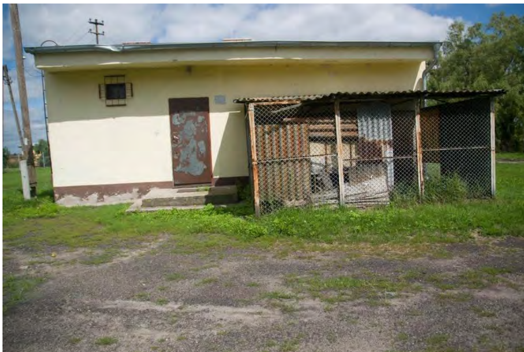
Fotografia 20 Zdjęcie obiektu – Minikowo
