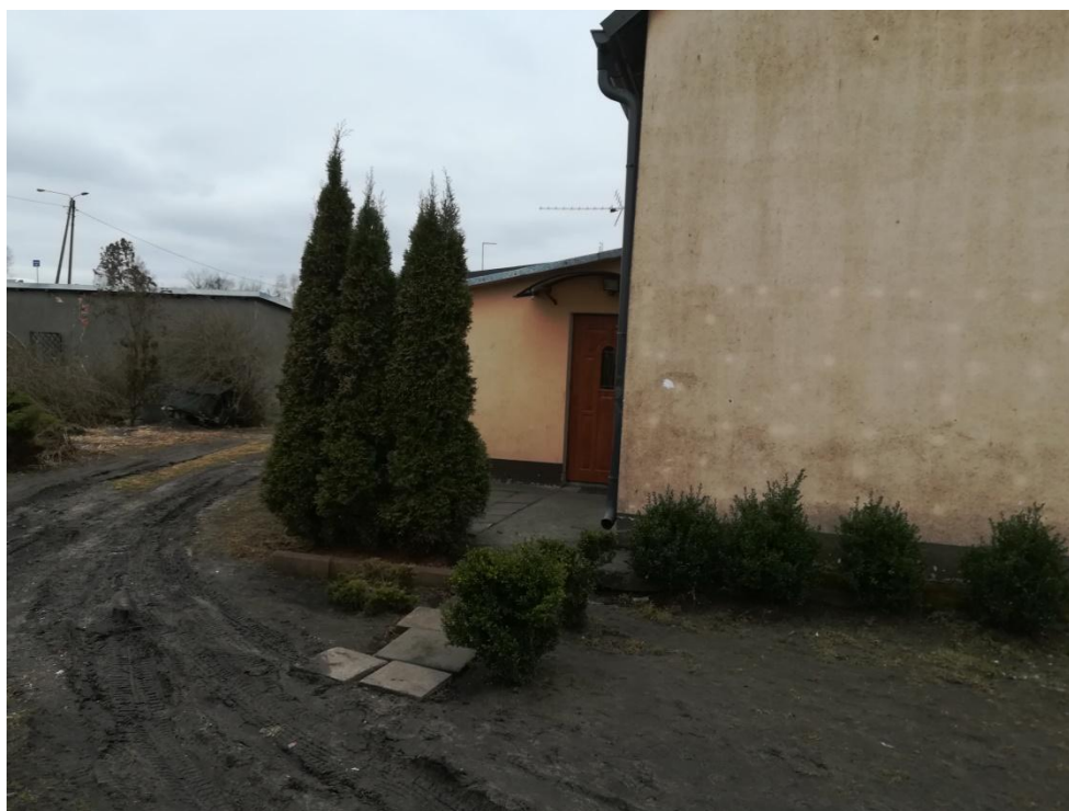
Fot. Budynek, ul. Wodna 7
