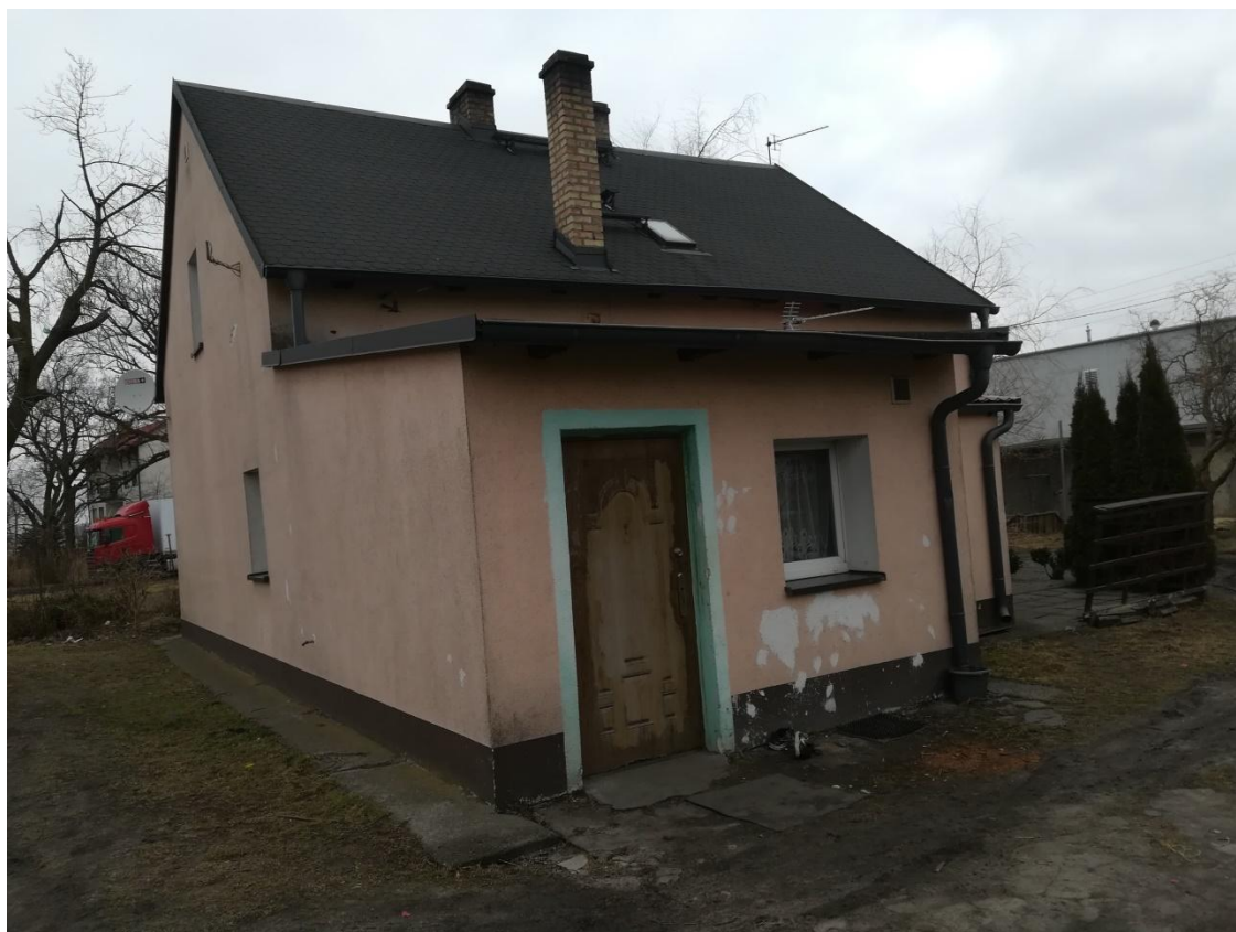
Fot. Budynek, ul. Wodna 7
