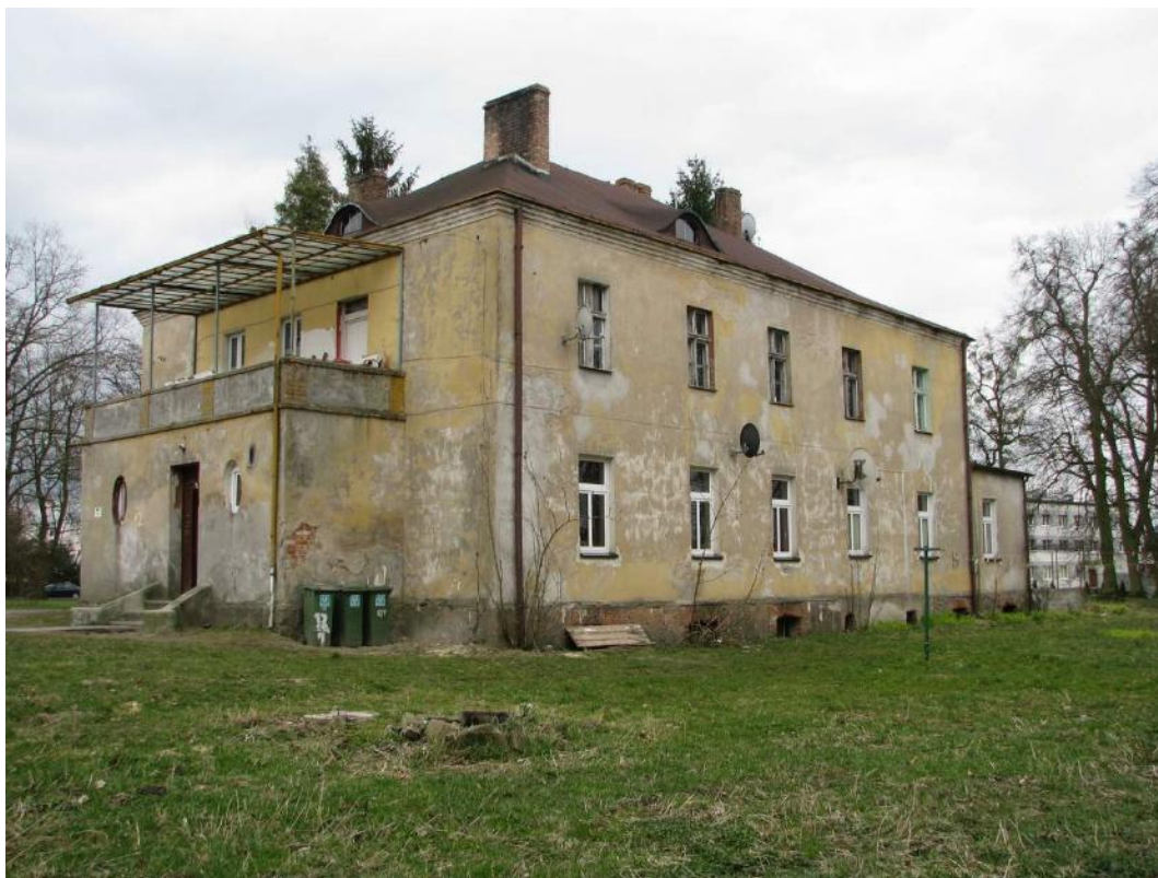
Zdjęcie 29 Budynek Pałacu.
